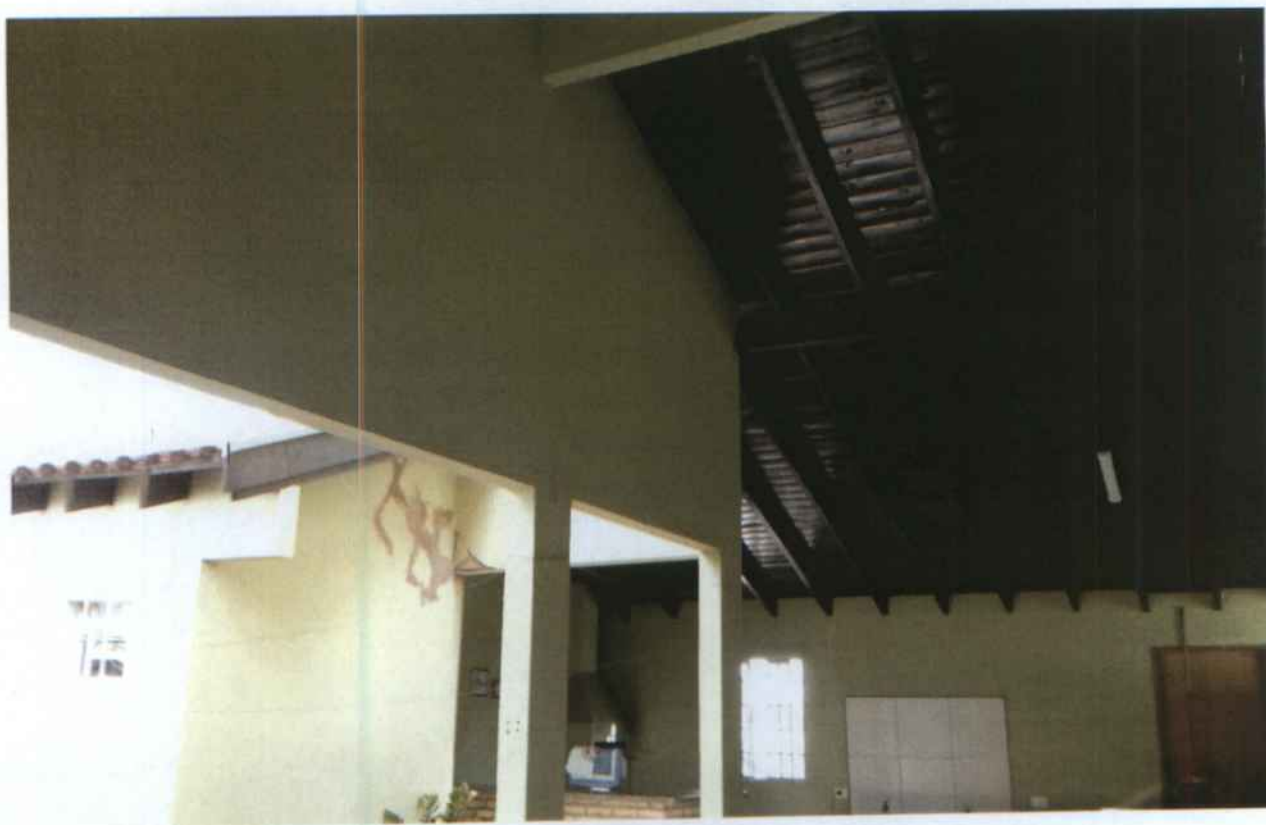
(FOTO 03 – MOSTRA A COBERTURA NA PARTE DOS FUNDOS DO IMÓVEL)
