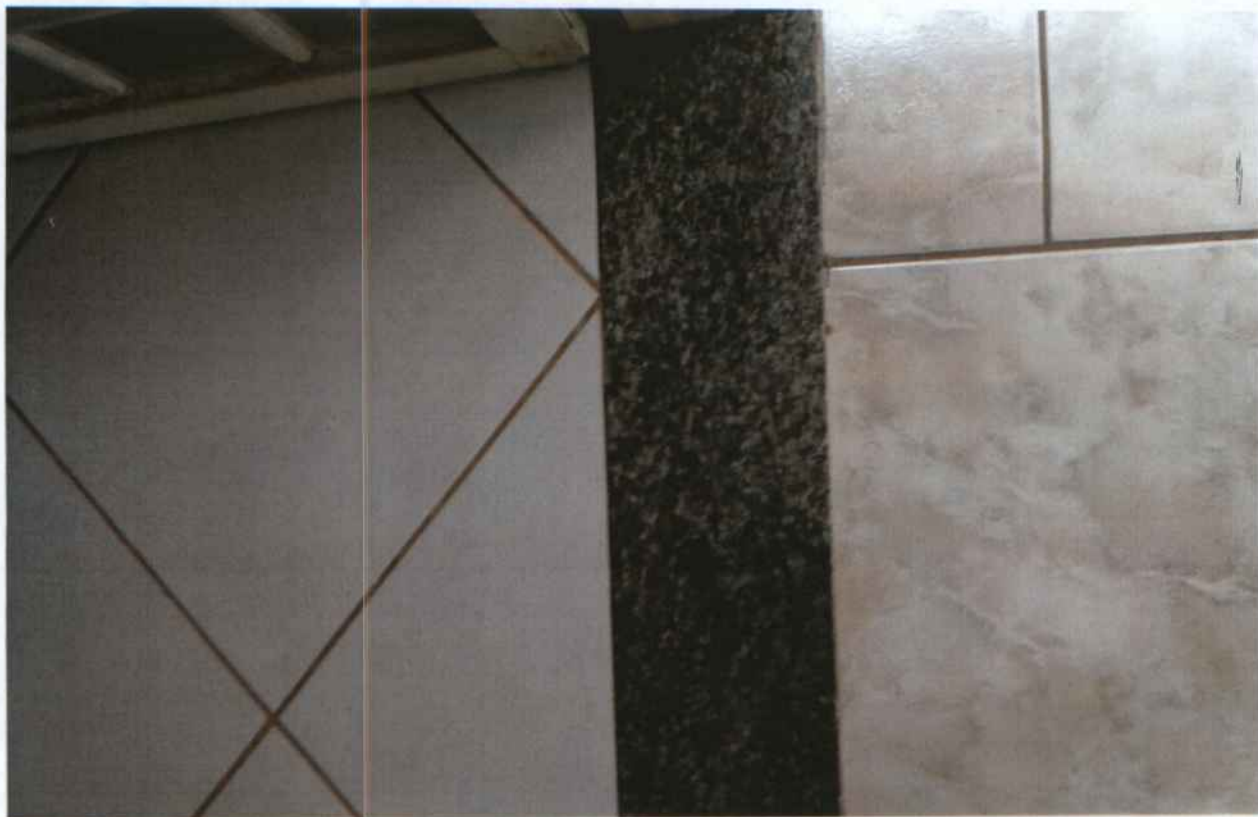
(FOTO 07 – MOSTRA PARTE DO PISO DA ÁREA EXTERNA E INTERNA – EM BOM ESTADO DE CONSERVAÇÃO)
