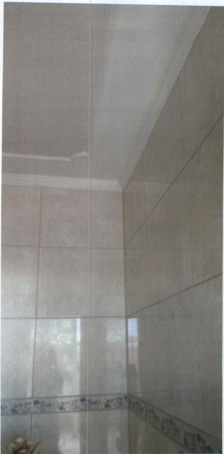
(FOTO 06 - MOSTRA ACABAMENTO INTERNO DO IMÓVEL: DETALHES EM GESSO E REVESTIMENTO DE PAREDE BRILHANTE, EM BOM ESTADO DE CONSERVAÇÃO)
